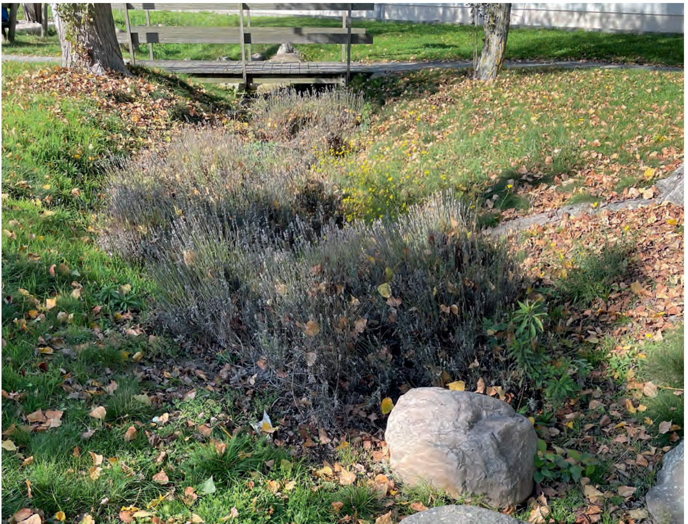
Abbildung 17: Bepflanzte Entwässerungsmulde (Leipzig, Probstheida)
