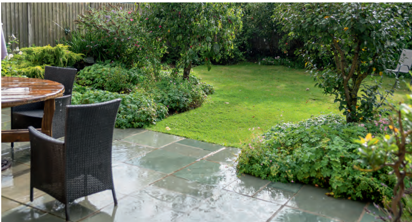
Abbildung 11: Unbelastetes Niederschlagswasser von einer Terrasse entwässert in den Garten
