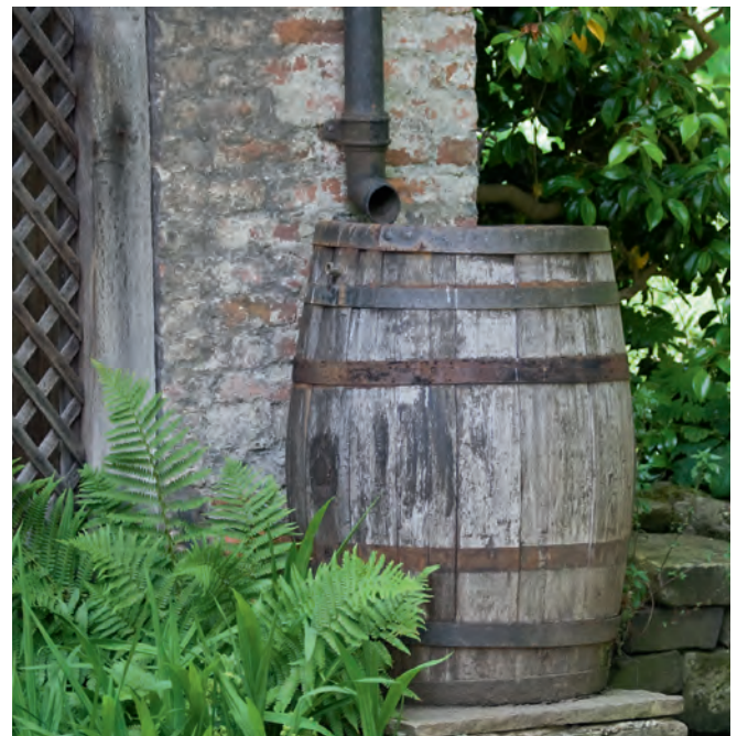
Abbildung 55: Eine einfache Lösung zur Niederschlagswasserspeicherung
