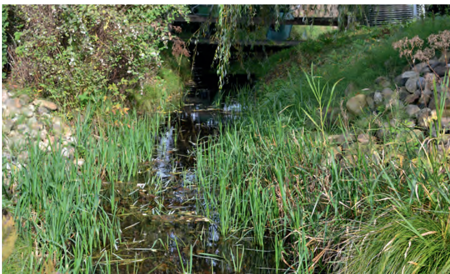
Abbildung 60: Feuchtbiotop als Retentionsraum
