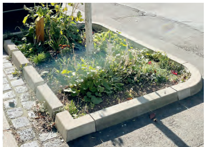
Abbildung 20: Baumrigolen mit Einlaufschlitzen in der Kochstraße, Leipzig
